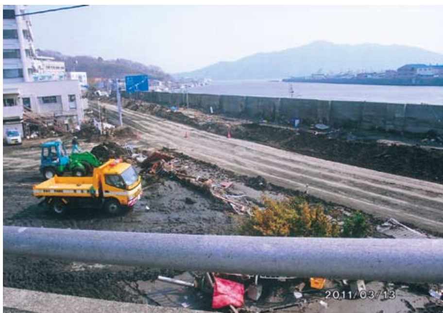
黄色いトラックの後ろが市役所です。津波は右に見える堤防を越えました。
