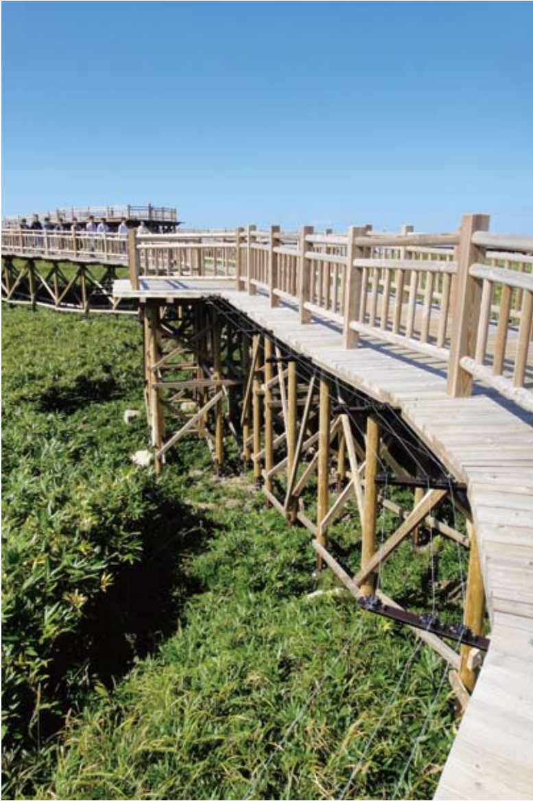
写真⑨ バリアフリーの高架木道(写真提供：知床財団)
