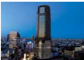
セルリアンタワー 東急ホテル
