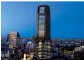
セルリアンタワー 東急ホテル
